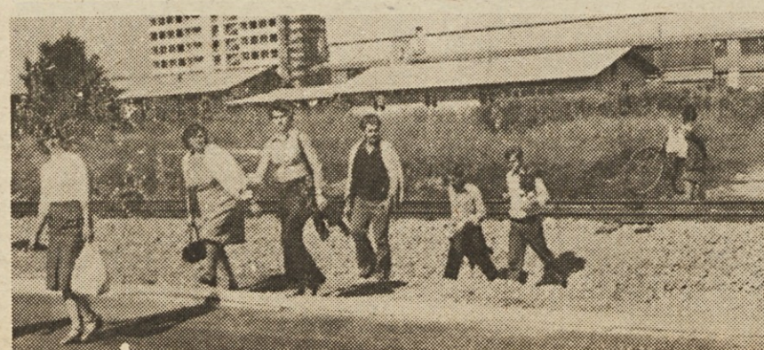
Takole je na progi, ko se konča delo na Stegnah.
