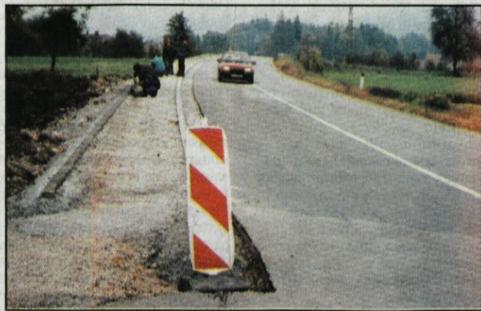
Fotografirali smo gradnjo pločnika ob cesti Krtina - Moravče. Pločnik bo zagotovil več varnosti vsem, predvsem pa šolarjem bližnje Osnovne šole Krtina.
