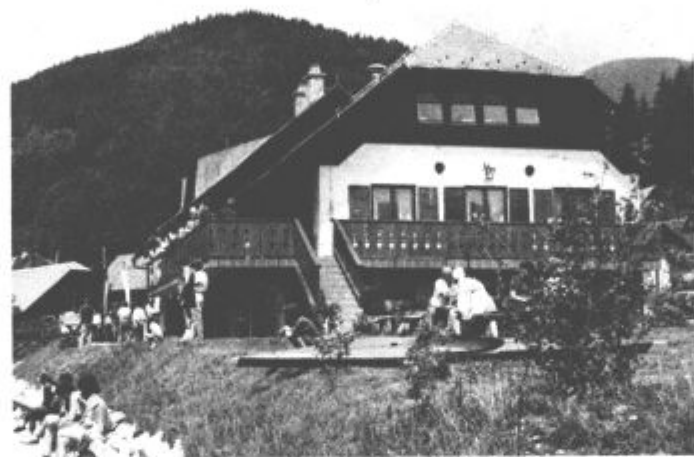
Center s spremljajočimi objekti je dobil pravo podobo
