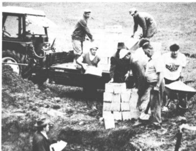
Takole izkoriščajo proste urice krajan spodnjega dela Lokovice od letošnjega aprila dalje. Več kot 100 prostovoljnih ur je opravilo že vsako gospodinjstvo. Še nekaj jih bo potrebnih, da se bodo lahko priključili na vodovod Velenje - Šoštanj. To naj bi se zgodilo sredi tega meseca.
