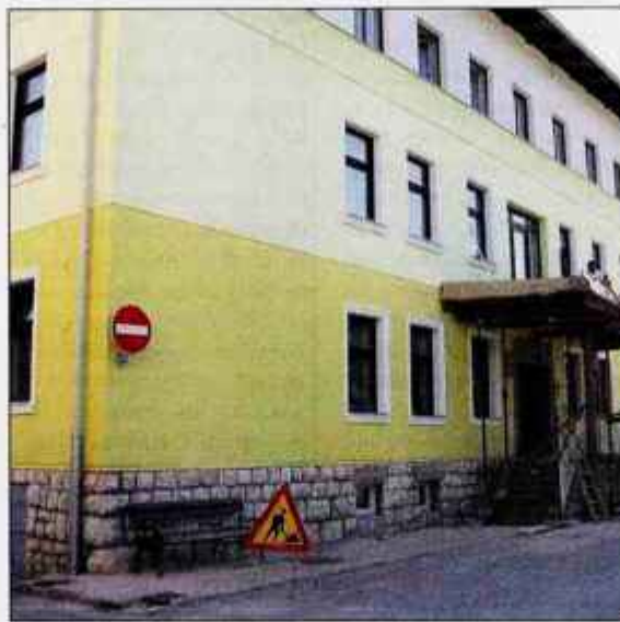
Občinska stavba v Bohinjski Bistrici dobiva nov zunanji videz, temeljito pa prenavljajo tudi notranjost.
