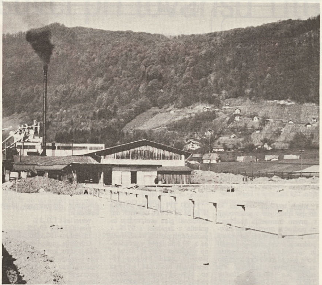
ZA TOZD TVP RASTEJO TEMELJI NOVE ZGRADBE
