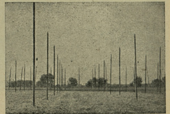
Zično ogrodje z železobetonskimi drogovi
