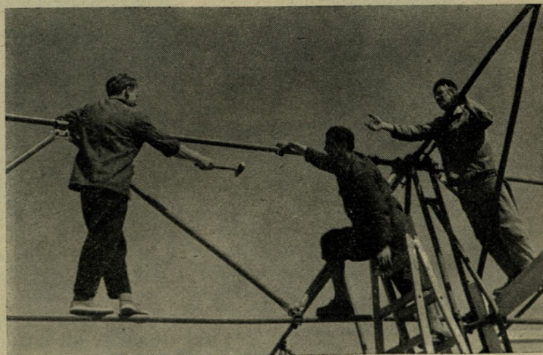
Tako so gradili gradbeni delavci poslopja Kmetijske srednje šole v Vrbi pri Žalcu in uspeli v rekordnem času!
