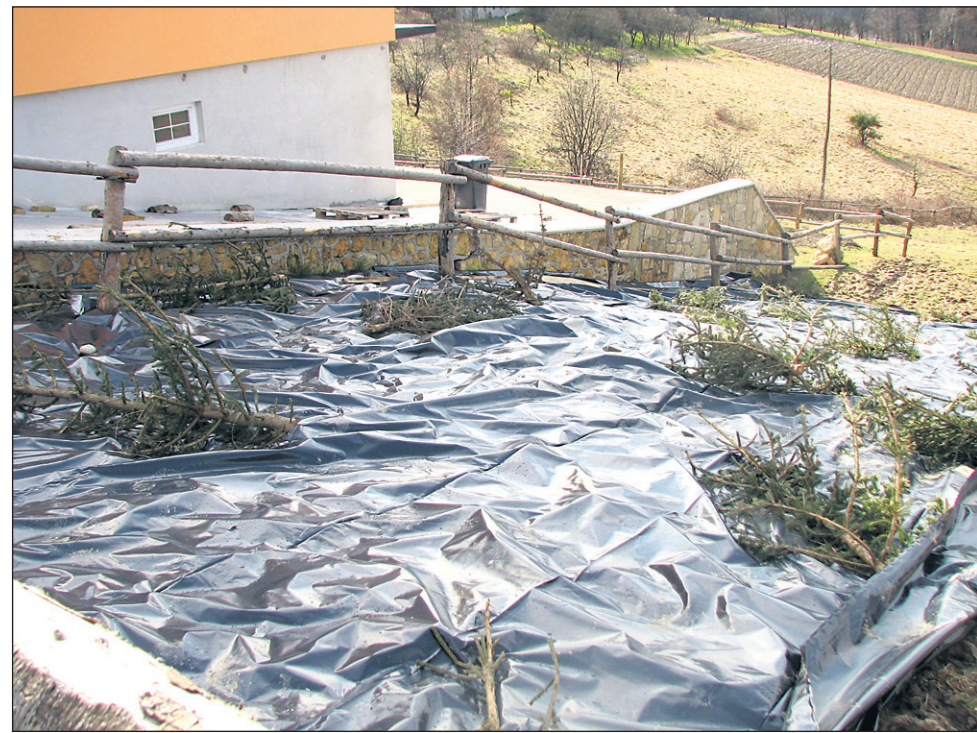
Plazenje celotnega hriba se je zaenkrat ustavilo tik ob hiši Marinovih; gasilci so največjo razpoko prekrili s folijo. Foto: SM
