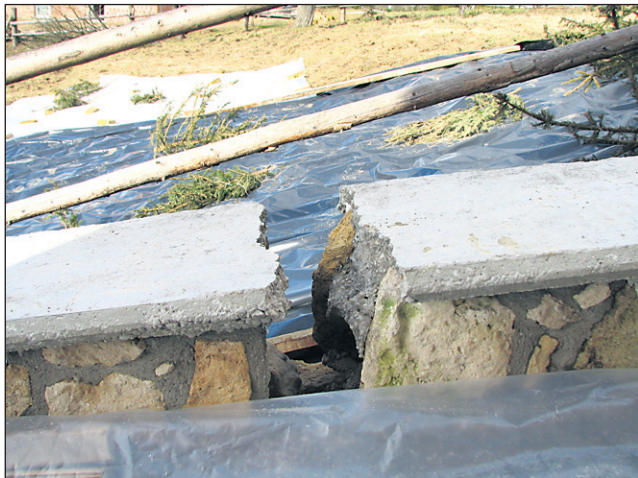
Tako je počil širok betoniran škarpni zid za temelj ograje dobra dva metra od roba hiše Foto: SM
