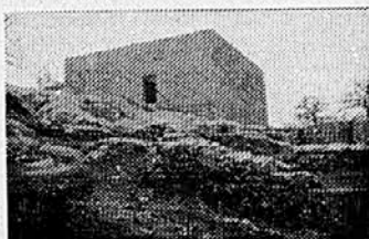
Obnovljen malograjski obrambni stolp
