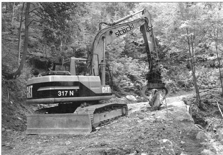
Na cesti, ki pelje proti Zavodicam in naprej proti Nazarjam, so utrdili strmo strugo hudournika in namestili podporni zid (foto: Marija Lebar)
