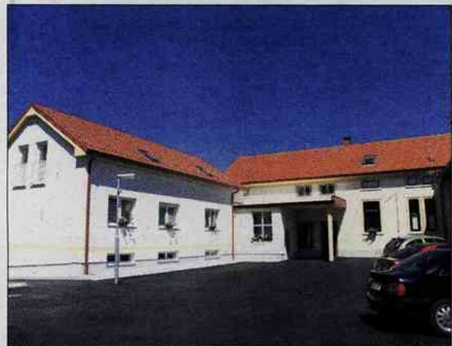
Večja občinska stavba v Preboldu. Tehničnega prevzema še ni bilo.
