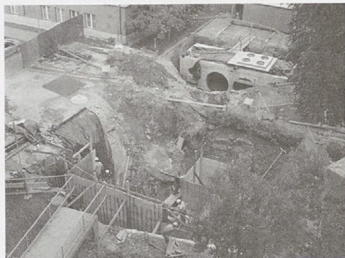
izgradnja zbiralnika meteornih vod pri Občini Trbovlje
