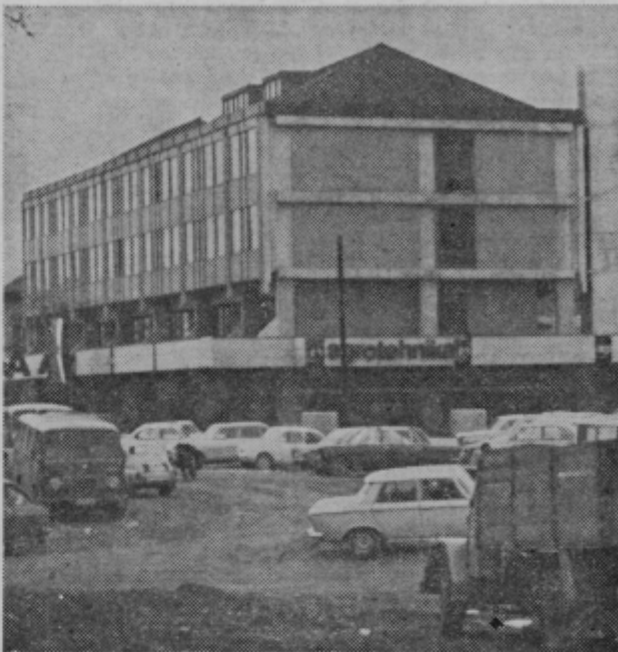
Po zaslugi Agrotehnike je Celje dobilo novo blagovno hišo. Zgradili so jo v Askerčevi ulici, na lokaciji, ki zlasti v prihodnje obeta zelo veliko. Ni naključje, da je ljubljanska Agrotehnika, ki ima v Celju že dolga leta svojo enoto, izbrala prav mesto ob Savinji za zgraditev doslej svoje največje blagovne hiše. Na to odločitev je vplivalo dejstvo, da je Celje središče močnega kmetijskega in sploh potrošnega središča, da prihajajo semkaj kupovat kmetijske stroje in drugo blago kmetje z vse Štajerske, Zasavja in celo hrvaškega Zagorja. In končno, dosedanji prostori Agrotehnike v Celju so bili prej ovira kot spodbuda za boljše poslovanje. Agrotehnika je postala najpomembnejši oskrbovalec slovenskega trga z zaščitnimi sredstvi za rastline, sicer pa sega njeno poslovanje na trg s kmetijskimi stroji, nadomestnimi deli zanje, na rezervne dele za avtomobile itd., itd. Celjska blagovna hiša ima 1500 kv. metrov prodajnih prostorov. Novost je konsignacijska prodaja kmetijskih strojev, pa tudi kmetijska posredovalnica, ki bo delala vsak prvi in tretji ponedeljek v mesecu. MB
