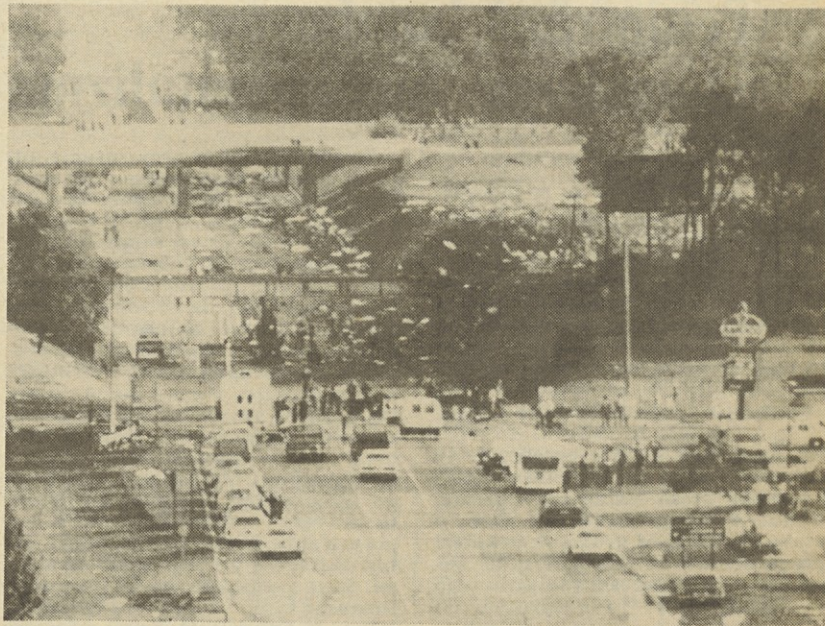
Pogled na avtocestno vozlišče, na katero je treščil DC-9
