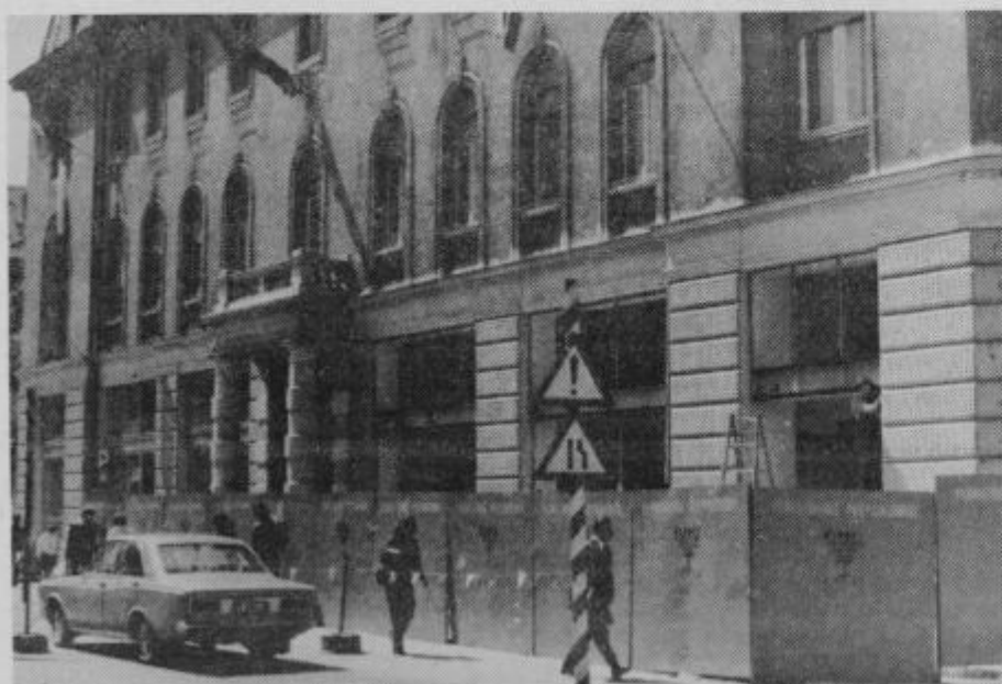
Narodni dom: obnove fasade pritličja
