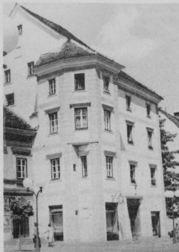
Tomšičev trg 17: izgled po rekonstrukciji fasade
