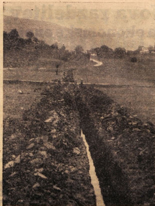
Tod bodo položili cevi za vodovod v Gabrovko
