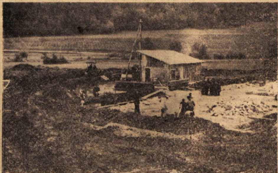
Gradbišče v Moravški dolini pod Gabrovko. Tod bodo zgradili hlev za 200 glav živine in druge potrebne objekte
