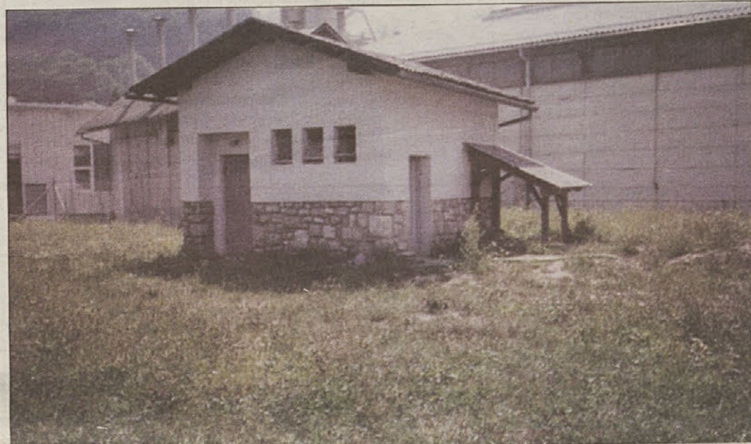
Stilles - osrednje črpališče sevniškega vodovoda
