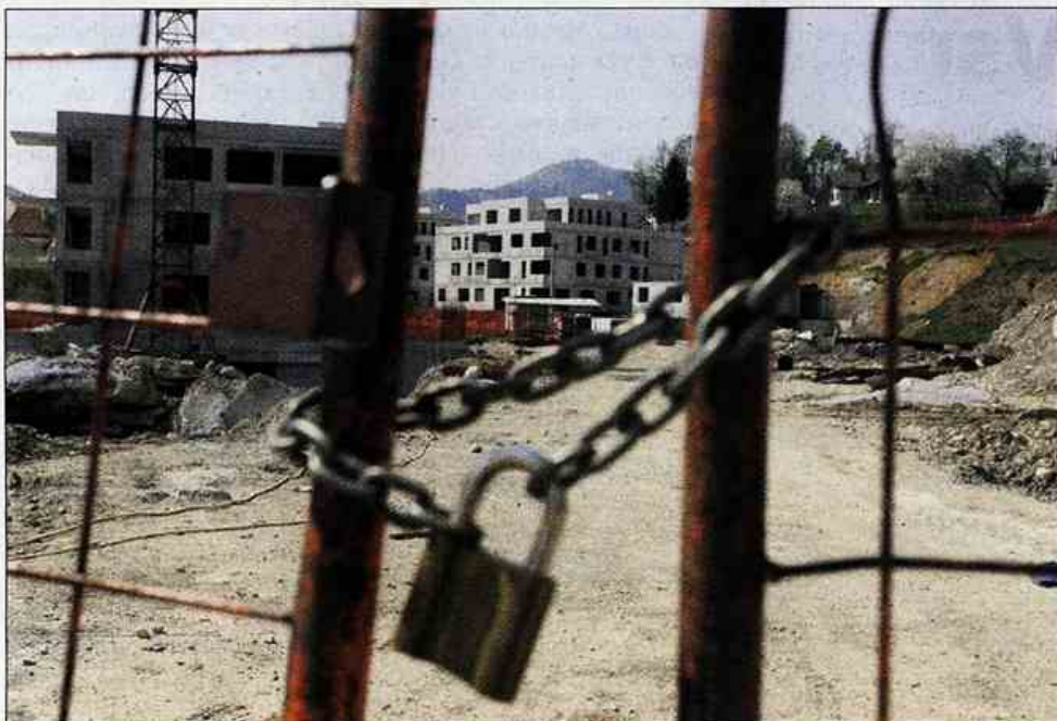
Vseh 157 stanovanj bi moralo biti končanih do poletja. Njihova gradnja miruje že mesec dni.
