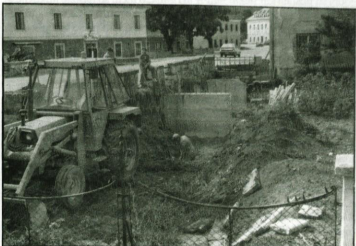
Gradnja peš poti ob mostu Gor. Logatcu (Foto: J.G.)
