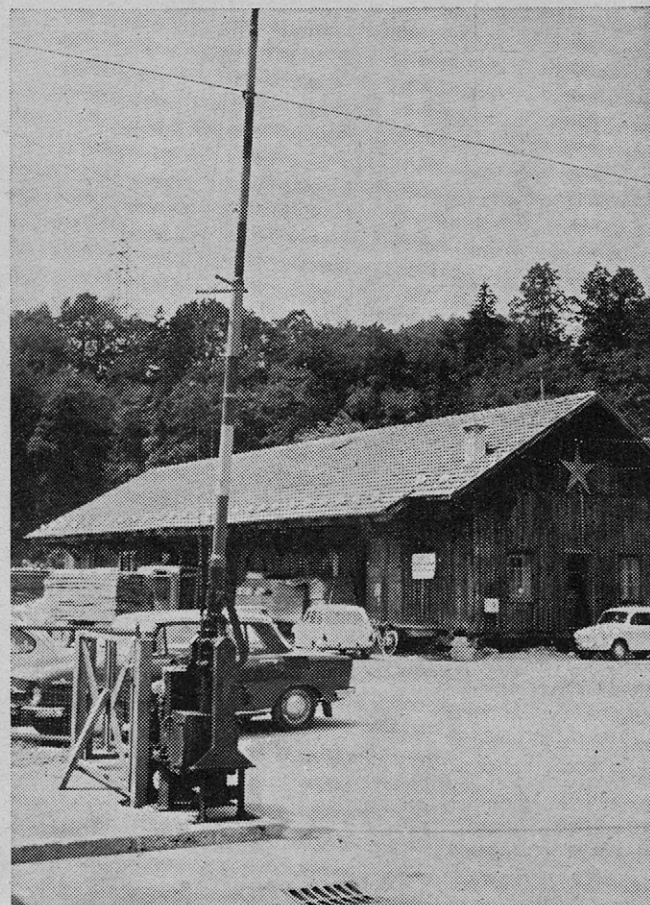
Rampa pri glavni vratarnici stoji že eno leto, toda res le stoji, saj so jo popravljali že vsaj petkrat, toda po nekaj dnevih je vedno ponovno odpovedala!
