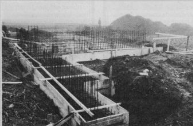
Gradbišče namakalnega sistema ob dravskem kanalu.
