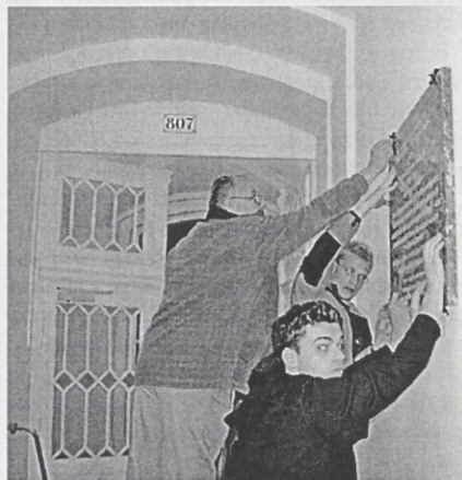
Pri montaži plošče v Knafljevi spominski sobi
