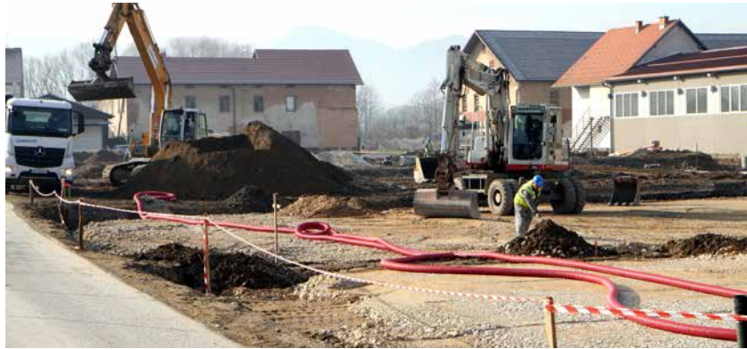
Gradbena dela v Poslovni coni Vrbje potekajo po načrtih.
