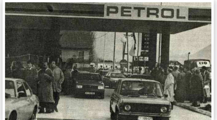
Savinjan, december 1992, str. 1
