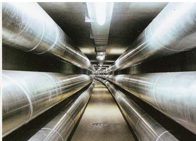
Učinkovitejši prenos energije: tiristorji, ki se vključujejo s svetlobo, pretvarjajo izmenični tok v enosmernega (levo). Podzemni vodi, izolirani s plinom, so primerni za urbana območja (desno).
