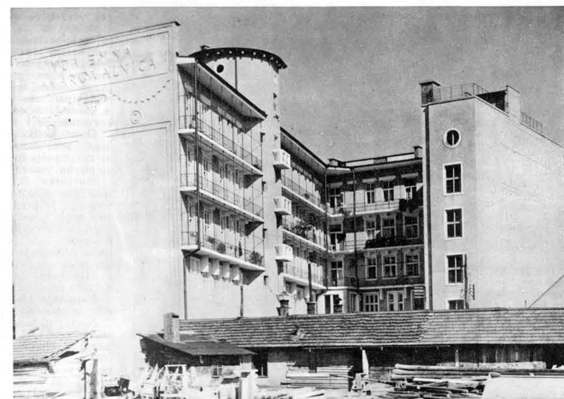
Dvoriščna fasada s pogledom z Dunajske ceste
