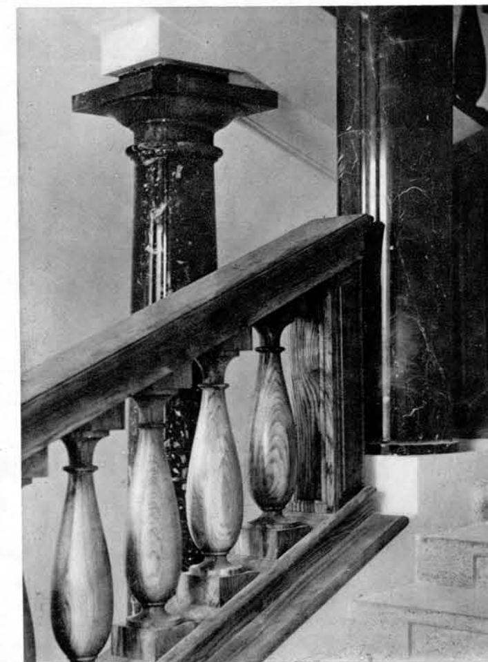
Detajl glavnega stopnišča. Stebri iz podpeškega, stopnice iz kraškega kamna
