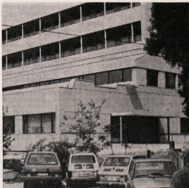
Izgradnja modernizacije celjske bolnišnice teče že šesto leto. Te dni pa zaključujemo z deli v enem traktu pritličja za 14 specialističnih ambulant z okoli 2000 m 2 površine, ki bodo pričele obratovati prihodnji mesec. Foto: Vili Šuster
