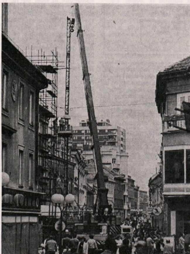
Pri adaptacijah objektov v mestnih središčih so često težave utesnjenosti gradbišča zaradi nemotenega prometa po ulicah.
