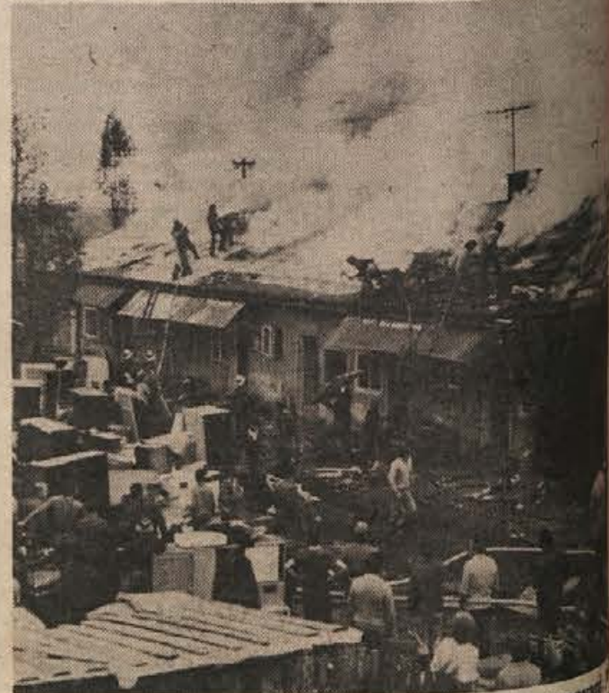
Stanovanjska baraka, v kateri je bilo 8 enosobnih stanovanj zgorela 1. oktobra ob 5. uri v Šalki vasi 90 pri Kočevju. Škoda je bila okoli 100.000 din, ker so opremo rešili. Sumijo, da je prišlo do požara zaradi kratkega stika. (Foto: Z. Vardijan)
