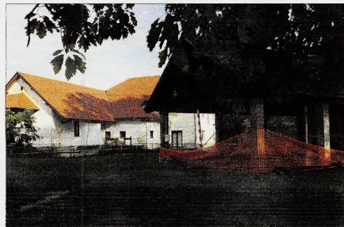
Na prostoru, kjer je bila nekač žaga, po demencializaciji pa je objekt že v lasti Občine Braslovče, želijo Letušani zgraditi priridritveni prostor
