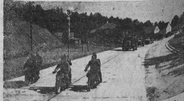
Delavci se peljejo po cesti in ugotavljajo, da je delo dobro opravljeno
