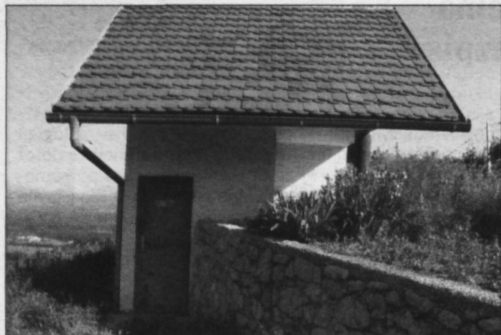
Vodohran Avguštine nad Kostanjevico
