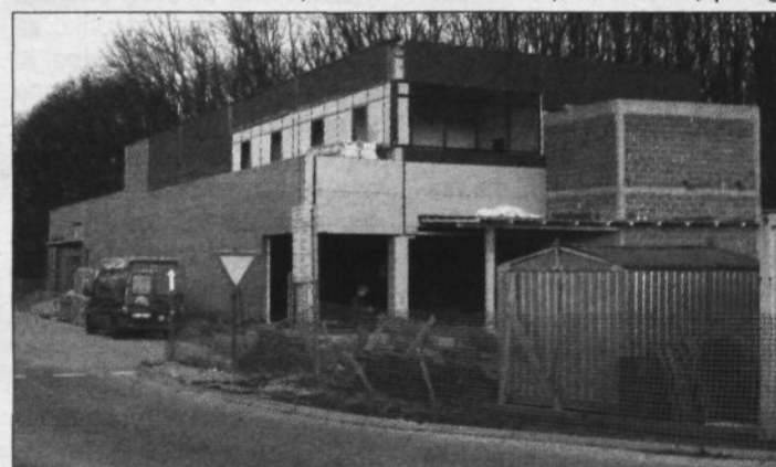
Trgovsko servisni center v gradnji
