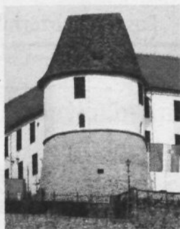
OBNOVITVENA DELA NA GRADU SEVNICA:
