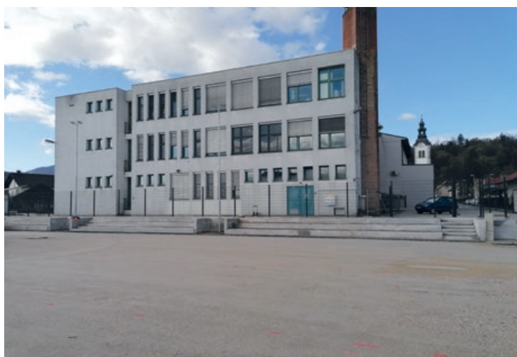
Igrišče pred asfaltiranjem ...
