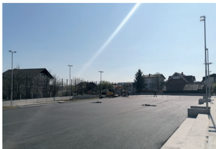
... in po asfaltiranju
