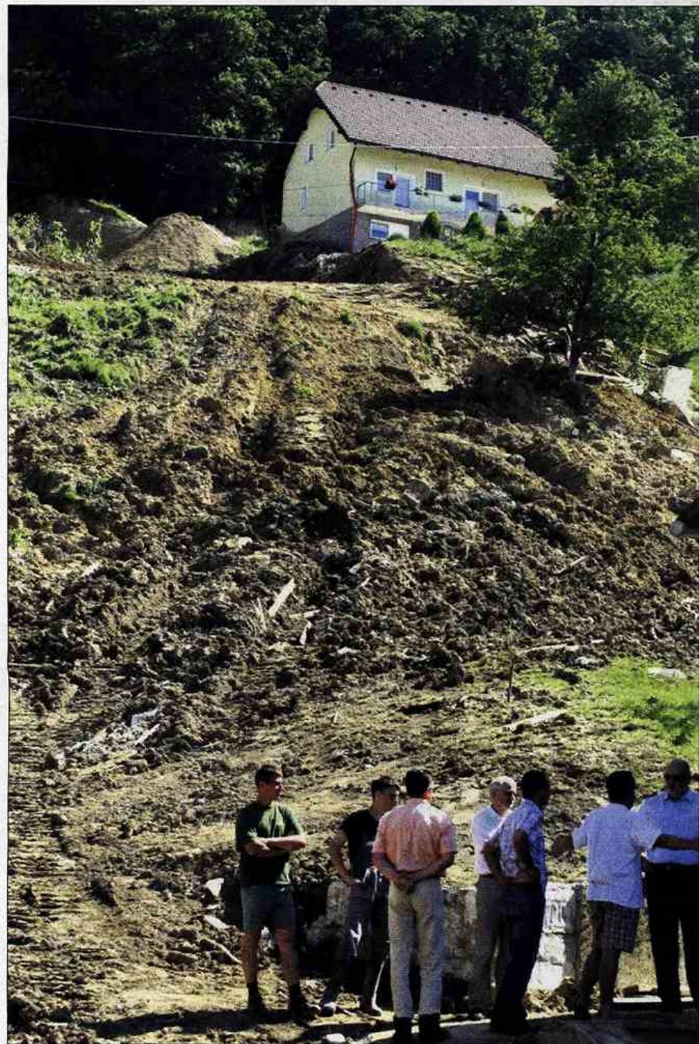
V Lokovici pri Šoštanju so s pomočjo državnih interventnih sredstev takoj začeli s sanacijo plazov.
