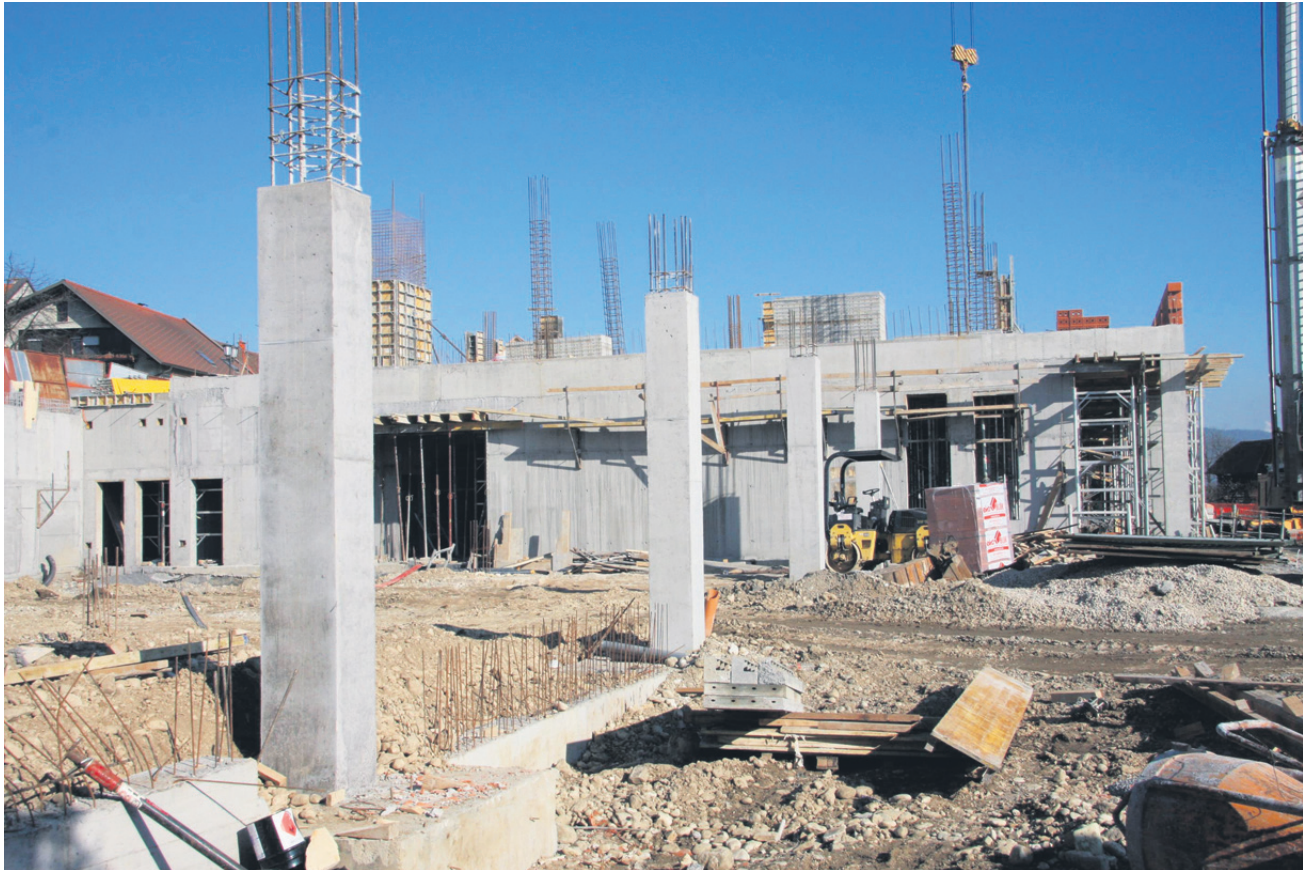
Gradbišče večnamenske dvorane v Braslovčah
