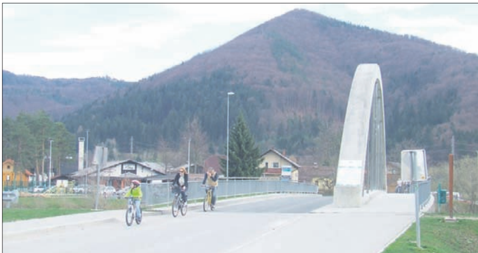
Tako imenovan Ločki most, zgrajen po eni od uničujočih poplav, pozdravi obiskovalce pred vstopom v Mozirski gaj in tudi v Loke pri Mozirju.
