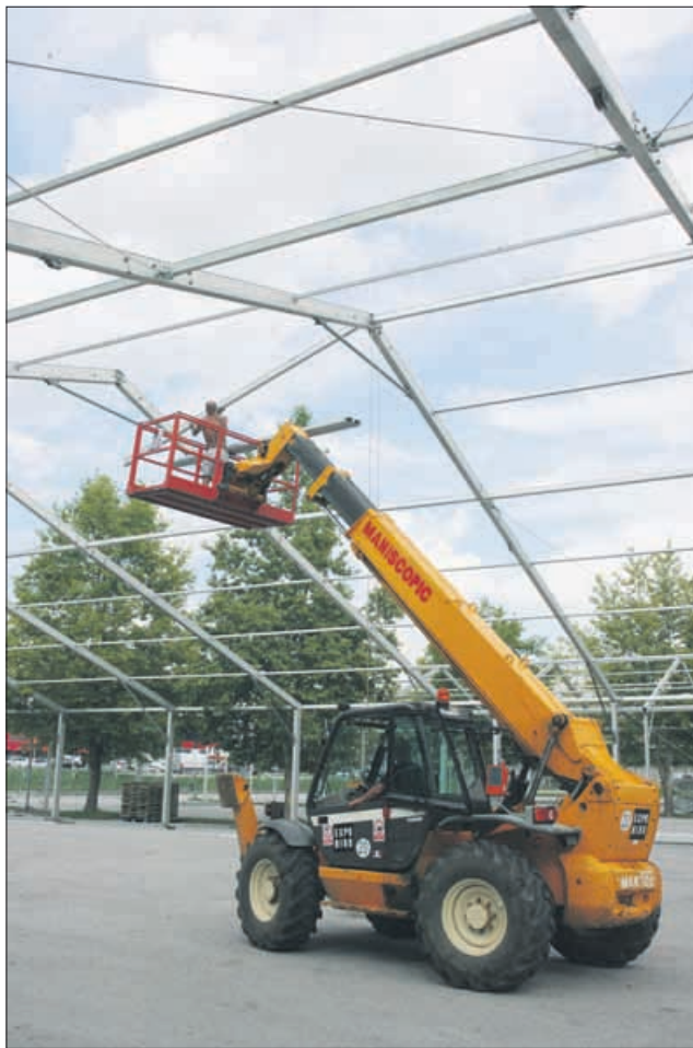
Montažne dvorane so na sejmišču začeli postavljati že prejšnji teden.
