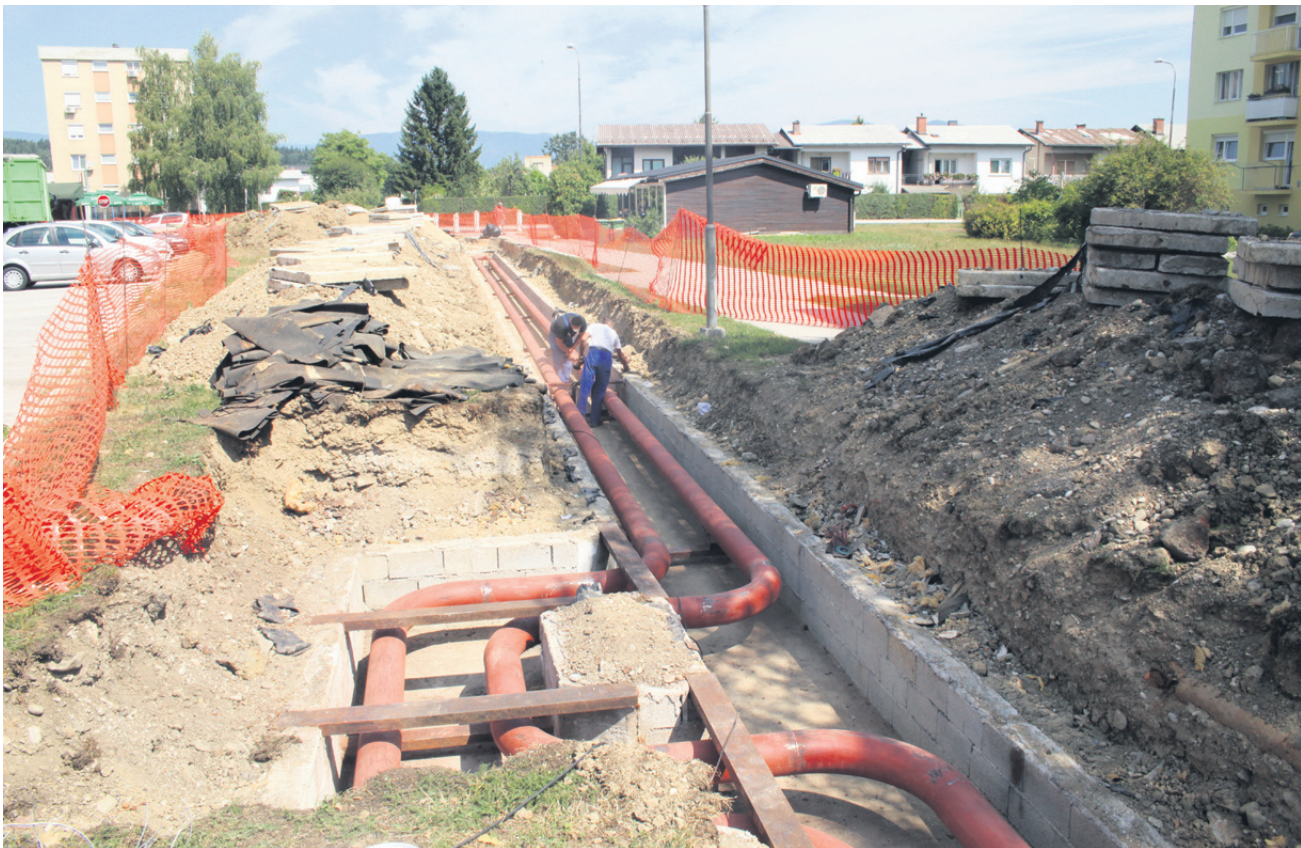
Obnavljanje vročevoda med Milčinskega ulico in Ulico frankolovskih žrtev
