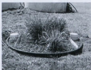
Rastlinska čistilna naprava
