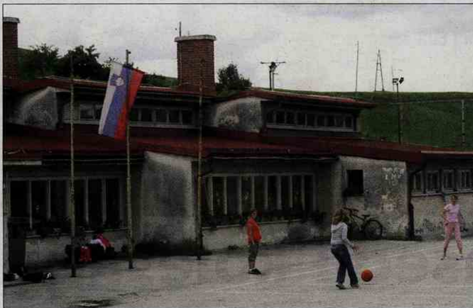
Šolo v Šentrupertu bodo konec septembra porušili.
