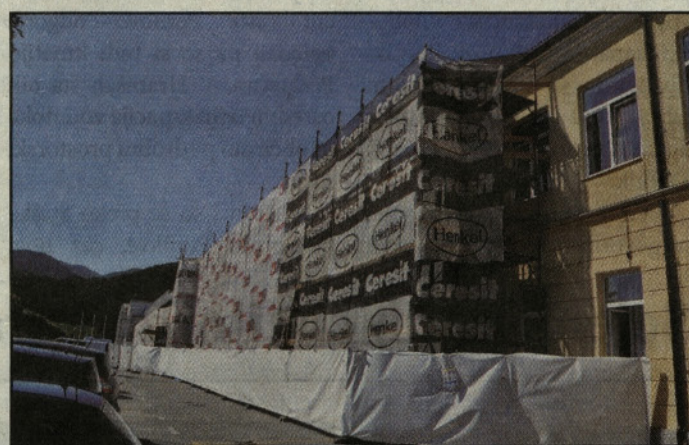
Del OŠ Prebold, kjer izvajajo energetska sanacija.
