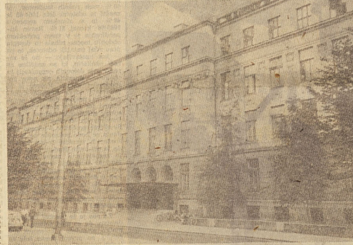
Na Aškerčevi 7 v Ljubljani: poslopje, v katerem so nastanjene kar tri strokovne šole — Tehniška šola za strojno stroko, Tehniška šola za kemijsko, metalurško, rudarsko in lesno industrijsko stroko ter Gradbena tehniška šola
