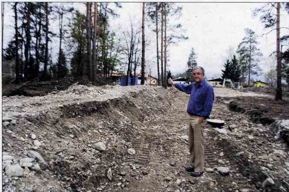
Krajanji so proti posegom v naselje in si želijo priklop na novozgrajeno kanalizacijo, širšo cesto s pogreznjenimi robniki do hiš, nasprotujejo javni razsvetljavi in zahtevajo izgradnjo zaščitne oziroma protihrupne ograje. Na sliki Viljem Reberšak.
