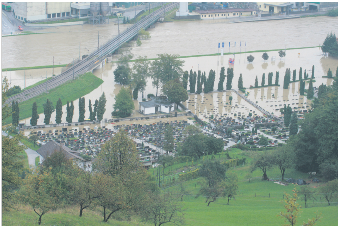
Pogled na poplavljen pokopališče v Laškem. Zdaj bo treba oceniti škodo, po prvih grobih ocenah naj bi v celi občini znašala okoli 10 milijonov evrov. (Foto: Damjan Kolšek)
