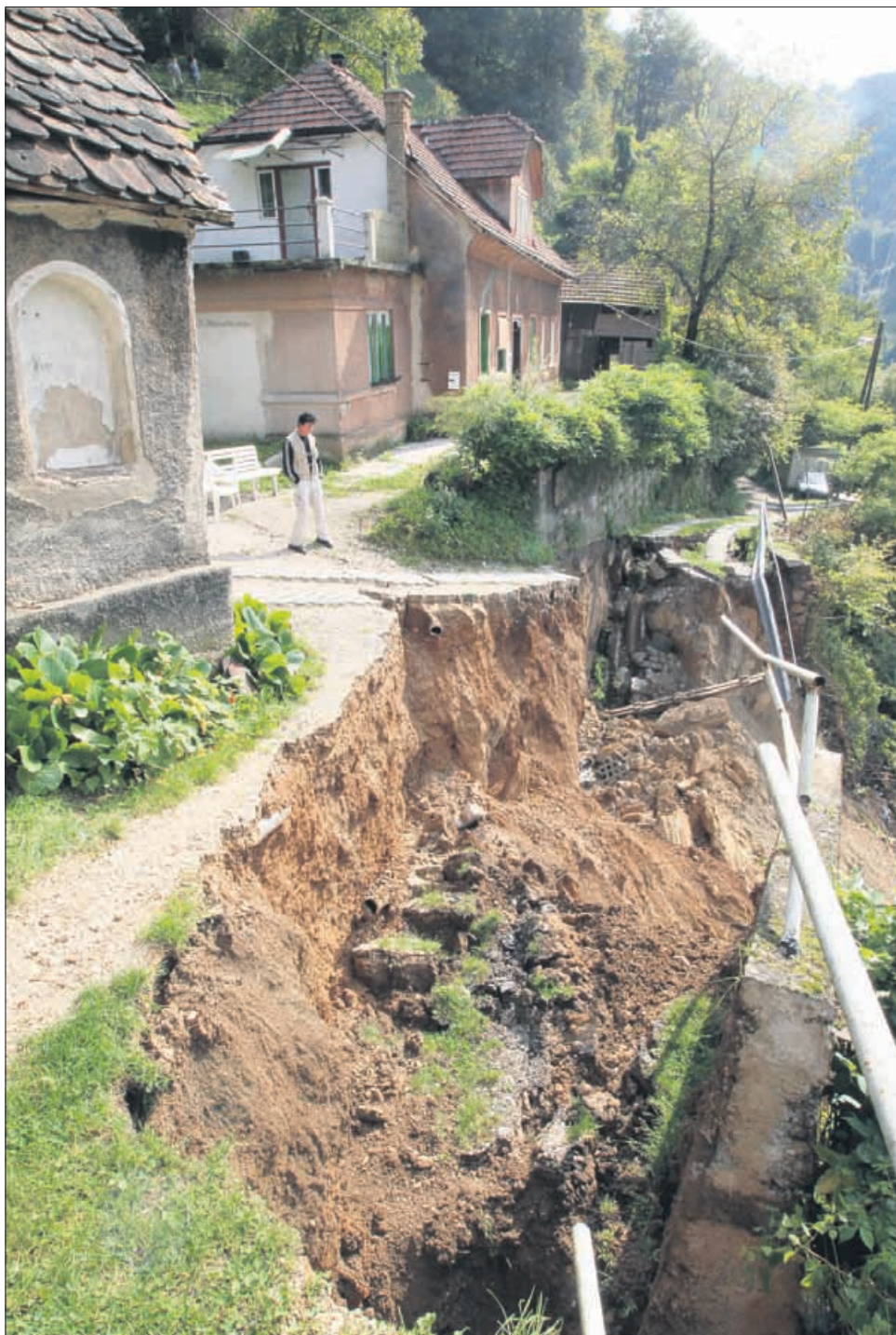
Na Obrežju pri Zidanem Mostu so imeli srečo v nesreči, saj plaz ni nikogar pokopal in da v prvih dveh hišah nihče ne prebiva. Kdaj bodo lahko vaščani ponovno zaživel normalno? Verjetno še nekaj časa ne.
