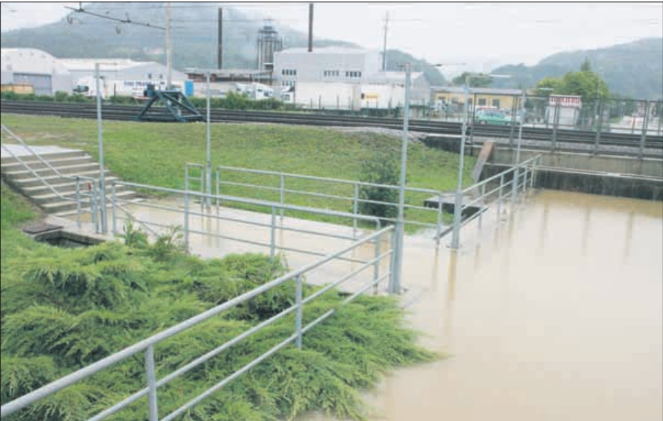
Šentjurčani so vajeni, da je ob močnejšem dežju železniški podvoz pri zdravstvenem domu poplavljen. Tokrat ga je bilo pod kalno vodo zgolj slutiti.
