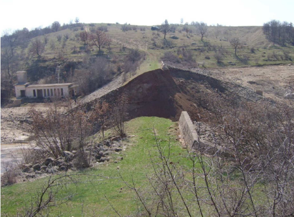
Porušena pregrada Ivanovo (Bolgarija) – iz predstavitve g.Toševa
