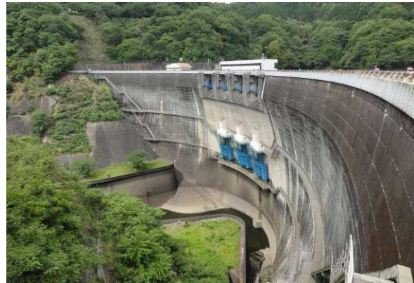
Slika 4. Pogled na ločno pregrado Amagase
