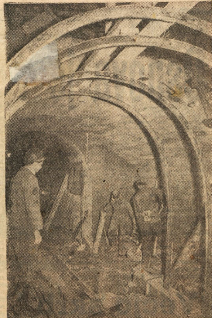
VELNO BOLJ UPORABLJAJO PRI DELU V JAMI NAMESTO LESA ŽELEZNE KONSTRUKCIJE
