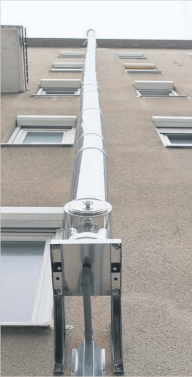
Tkalska ulica 3a. Tam so se lastniki vendarle uspeli dogovoriti in urediti zunanje dimnike za pravilen odvod dimnih plinov. Stanovalci pravijo, da je sprva bilo – predvsem zaradi neosveščenosti glede nujnosti ureditve ustrezne dimniške napeljave – kar nekaj dvomov. Toda skupen pogovor in pojasnitev nastale situacije sta pripeljala do pravilne rešitve. Naložba za eno stanovanje za obnovo dimnikov je – upoštevajoč kvadraturo stanovanja – znašala od 500 do 800 evrov. Ob tem je treba vedeti, da je bilo nekaj denarja zbranega že v njihovem rezervnem skladu. V bloku je 15 stanovanj.
