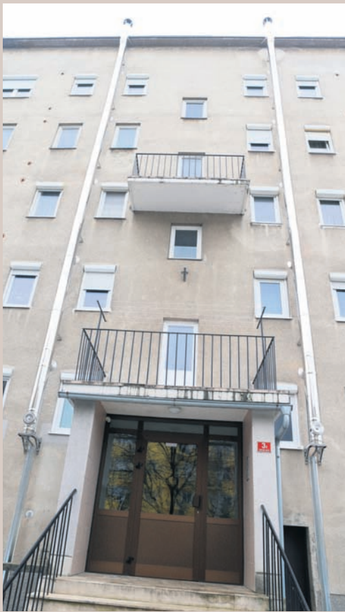
Tkalska ulica 3a. Tam so se lastniki vendarle uspeli dogovoriti in urediti zunanje dimnike za pravilen odvod dimnih plinov. Stanovalci pravijo, da je sprva bilo – predvsem zaradi neosveščenosti glede nujnosti ureditve ustrezne dimniške napeljave – kar nekaj dvomov. Toda skupen pogovor in pojasnitev nastale situacije sta pripeljala do pravilne rešitve. Naložba za eno stanovanje za obnovo dimnikov je – upoštevajoč kvadraturo stanovanja – znašala od 500 do 800 evrov. Ob tem je treba vedeti, da je bilo nekaj denarja zbranega že v njihovem rezervnem skladu. V bloku je 15 stanovanj.
