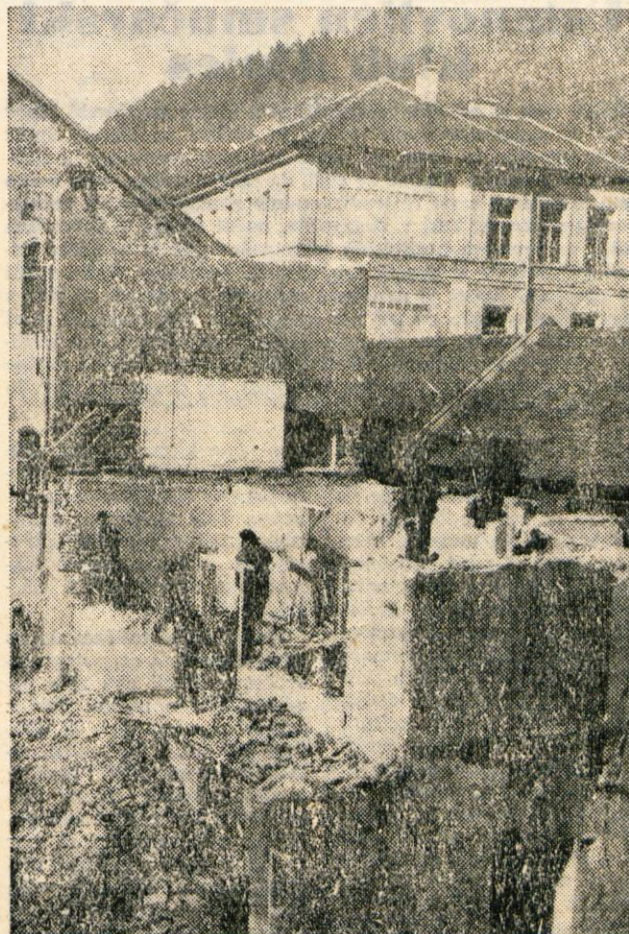
V Bračičevi ulici v Trzinu te dni pripravljajo prostor za gradnjo novega trgovskega lokala, ki ga bo zgradilo ljubljansko podjetje Veletekstil. — Foto: Franc Perdan
