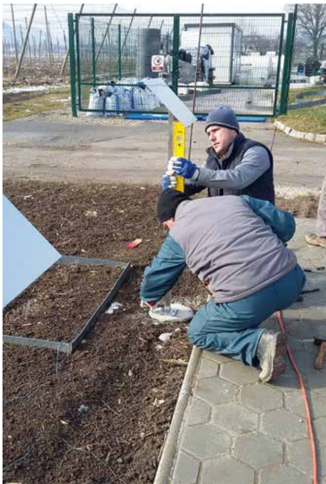
Montaža nosilcev za označevalne table
