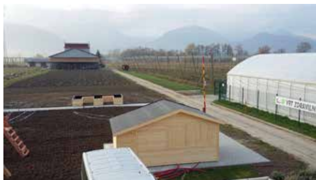
Zemeljska dela so zaključena. Nova tlakovana pot in leseni objekti so že postavljeni.
