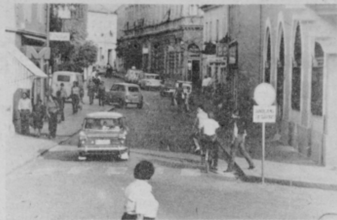
Na prehodu za pešce (foto M. Ozmec)
