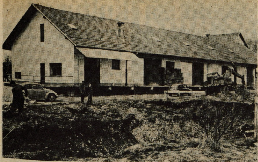
Avto-moto društvo iz Cerklje je začelo graditi za cerkljanskim združenim domom društveni dom. Gradbeni dela je zaupalo domačemu Obrtnemu podjetju. — Foto: F. Perdan
