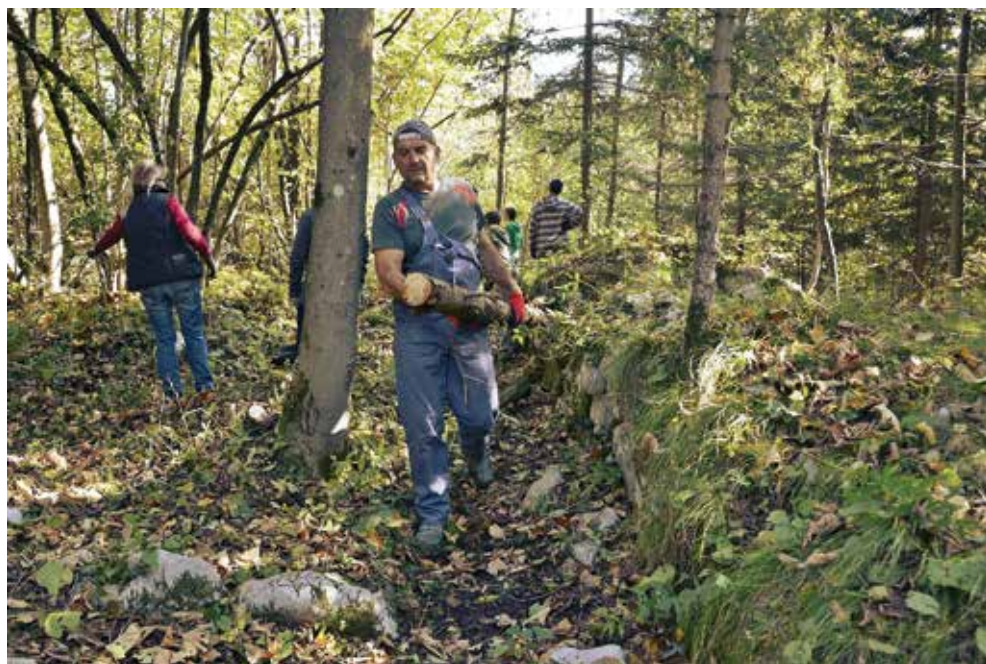
367. Cesarski vrh, prostovoljci pri čiščenju zidu, 30. september 2017.
