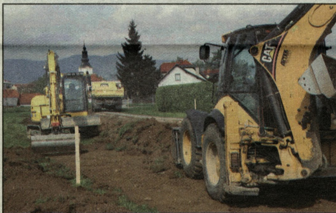
Gradnja parkirišča pri pokopališču na Polzeli
