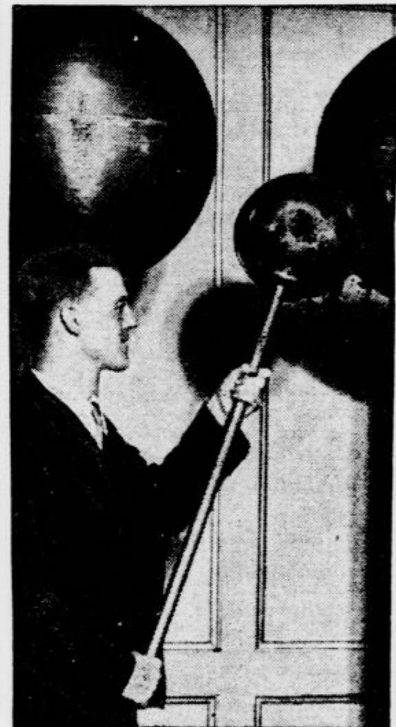
Prof. van Graaff je konstruiral novo aparaturo za proizvajanje umetnih bliskov. Obe veliki krogli sta pola, med katerima švigajo električne iskre. Napetost, ki je potrebna za proizvajanje takšnega bliska, znaša »malenkost« 2 milijonov voltov
